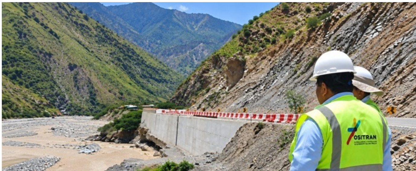
EL REGULADOR VERIFICA DRENAJES, Puentes, TALUDES Y DEFENSAS RIBEREÑAS ANTES DE LA TEMPORADA DE LLUVIAS.
