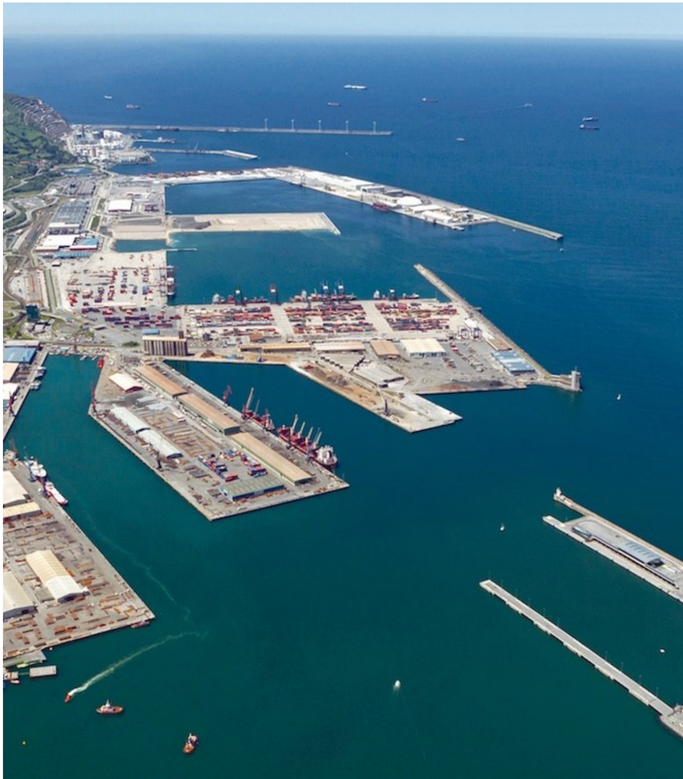
VISTA GENERAL DE LAS INSTALACIONES DEL PUERTO DE BILBAO.
